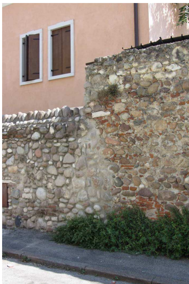
Figura 18 Punto di contatto tra la muratura ex-novo e il tratto a confine con l'area di progettazione
