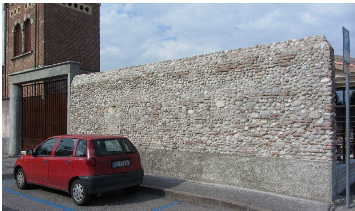
Figura 7 Sezione 3 della muratura in sasso
