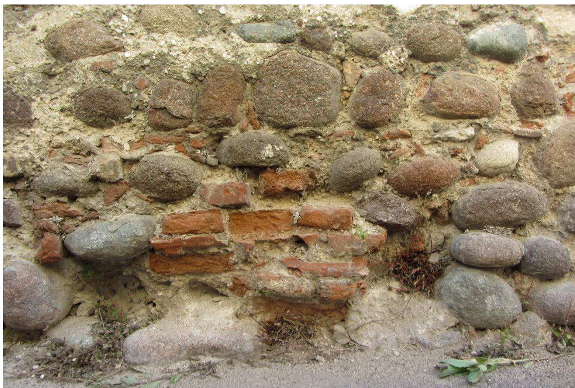
Figura 4 Esempi di elementi incoerenti inseriti all'interno del muro di cinta
