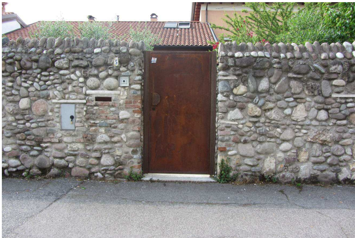
Figura 6 Muratura realizzata ex-novo ed apertura nella stessa con cancello
