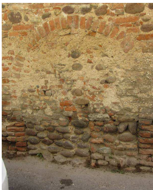
Figura 3 Aperture murate, visibili sulla superficie del muro di cinta
