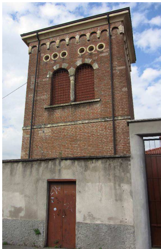
Figura 9 Cabina elettrica presente all'interno del PUA n. 612 e apertura di accesso realizzata nel muro perimetrale
