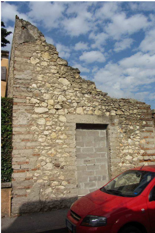
Figura 11 Apertura, ad oggi murata, presente nel muro di cinta lungo vicolo Abazia
