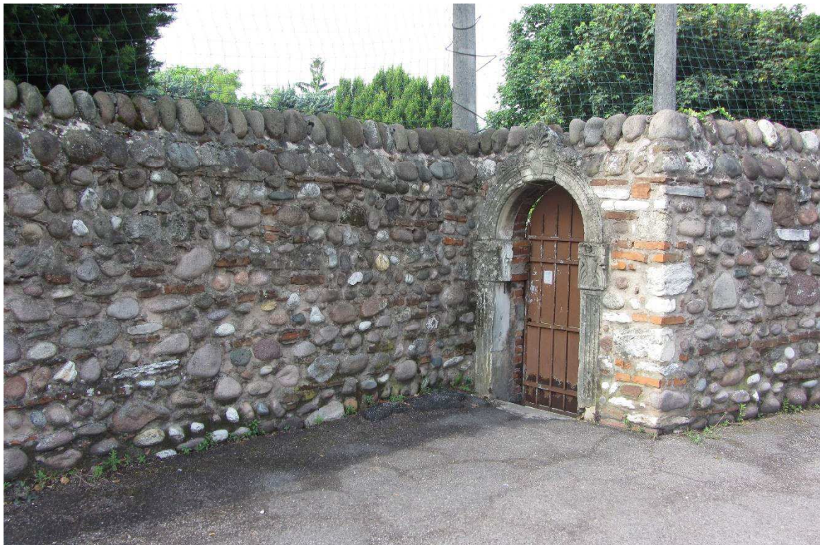
Figura 15 Esempio rappresentativo della tipologia originaria della muratura in sasso, disposta lungo la sezione 6
