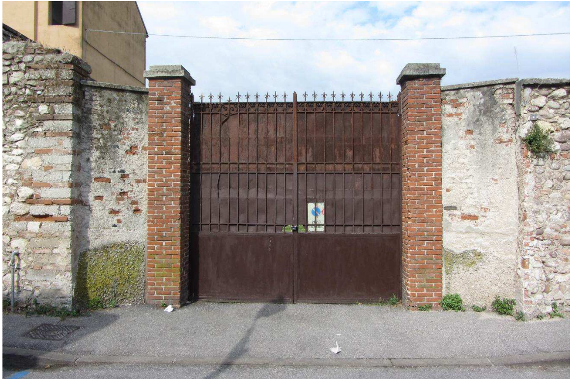
Figura 10 Accesso carroia realizzato nella sezione 4 del muro di cinta in sasso
