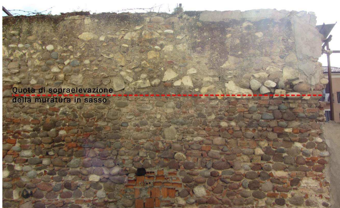
Figura 2 Individuazione della linea di attacco della sopraelevazione della muratura
