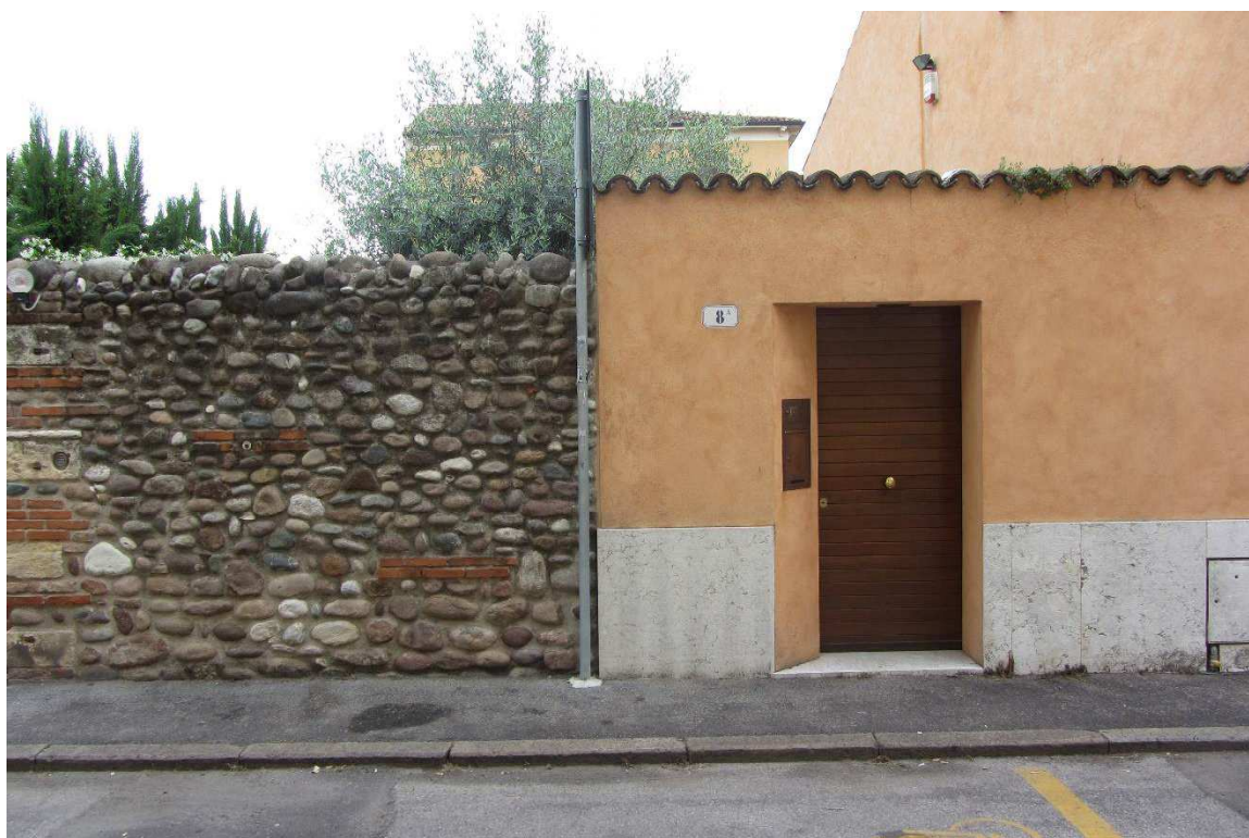
Figura 19 Punto di contatto tra la muratura ex-novo, realizzata secondo le tecniche tradizionali, e la muratura intonacata
