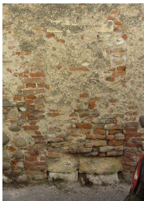
Figura 3 Aperture murate, visibili sulla superficie del muro di cinta
