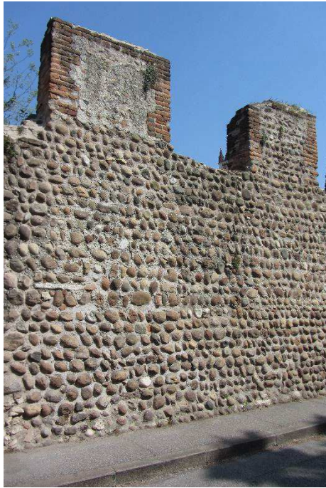
Figura 14 Merlature realizzate all'interno della sezione 5
