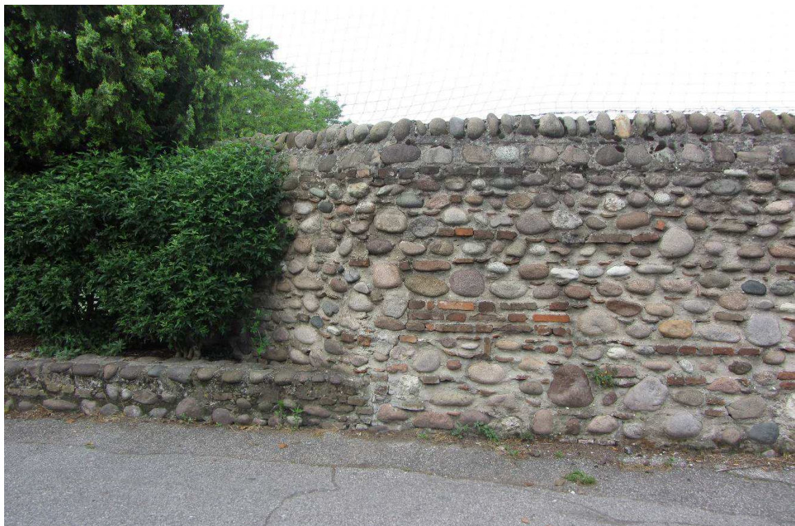
Figura 16 Sviluppo della muratura in prossimità delle aiuole verdi
